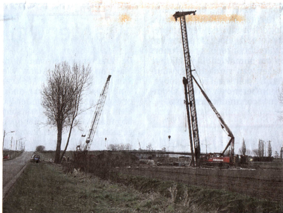
Momenteel is een firma bezig met het heien van de 24 palen die de windmolen op zijn plaats zullen houden.
